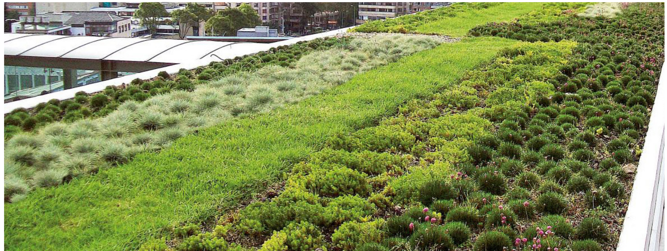
Pluri végétalisation toiture
